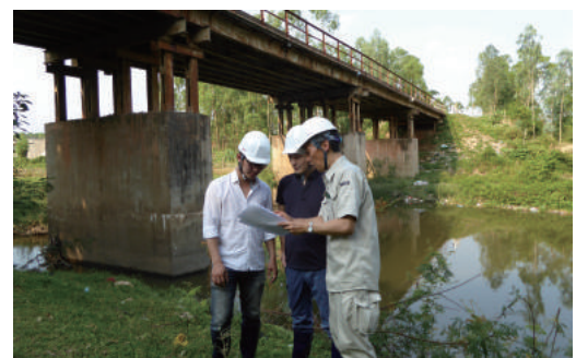
橋梁の共同現地観測 (ベトナム)
